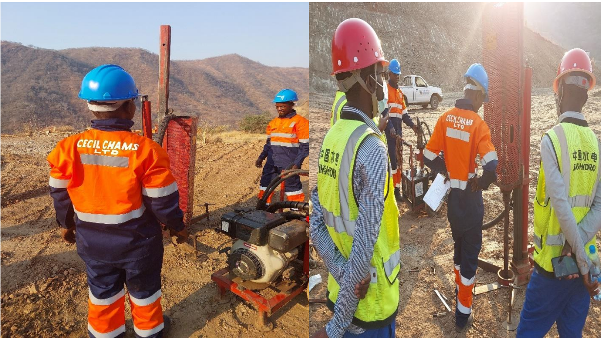
KAFUE LOWER GORGE LOWER GEOTECHS-SPT
